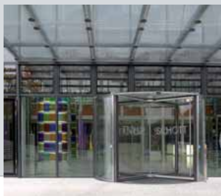
Schott AG | MAINZ | J • S • K Architekti | Typ GGG | plnoautomatické | 4-krídlové | opláštěné ušľachtilou oceľou | nočný uzáver | pohon skrytý v podlahe
