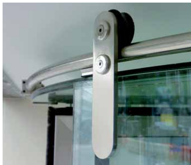
Vonkajší nočný uzáver – presklené krídlo s bodovými držiakmi
